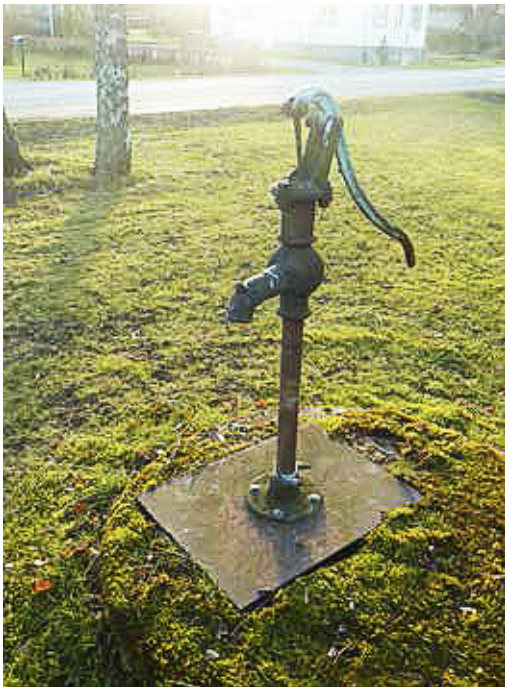
SIBELIUKSENKADUN KAIVO. (KUVA AW)
