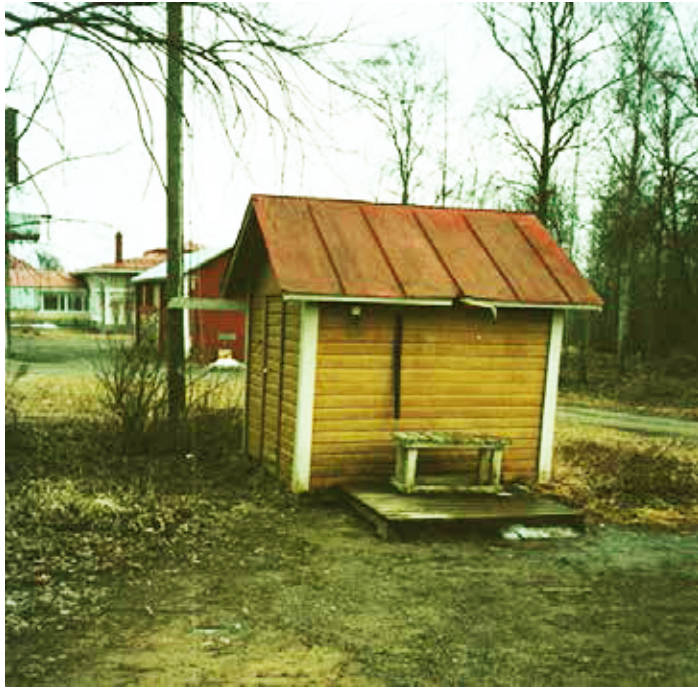
VANHAN SAIRAALAN KAIVON SÄHKÖPUMPUSTA SAA YHÄ KAIVOVETTÄ. (KUVA RS 2003)
