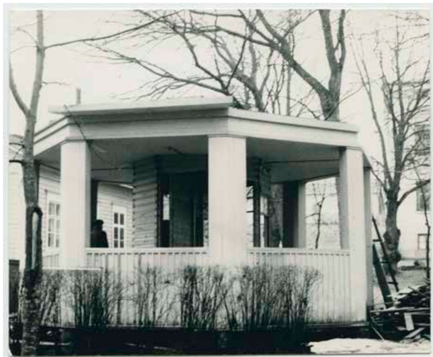
RAATIHUONEENPUISTOSSA OLI 1960-LUVULLE SAAKKA KIOSKI, JOSSA KOKOONNUTTIIN SAMAN TAPAAN KUIN KAIVON LUONA. (KUVA OTA)
