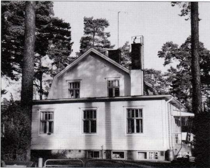
Vanhaa rakennusta kiertää massallisesti sopimaton laajennus, joka peittää alleen rakennuksen aikaisemman volyymin. Tilannetta ei pelasta se, että laajennusosan ikkunat ovat ilmeisesti peräisin vanhasta rakennusrungosta (Hanko)
