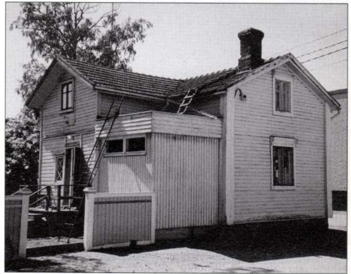
Rakennukseen on hankittu lisätilaa arkkitehtonisesti sopimattomalla laajennuksella (Kaskinen)
