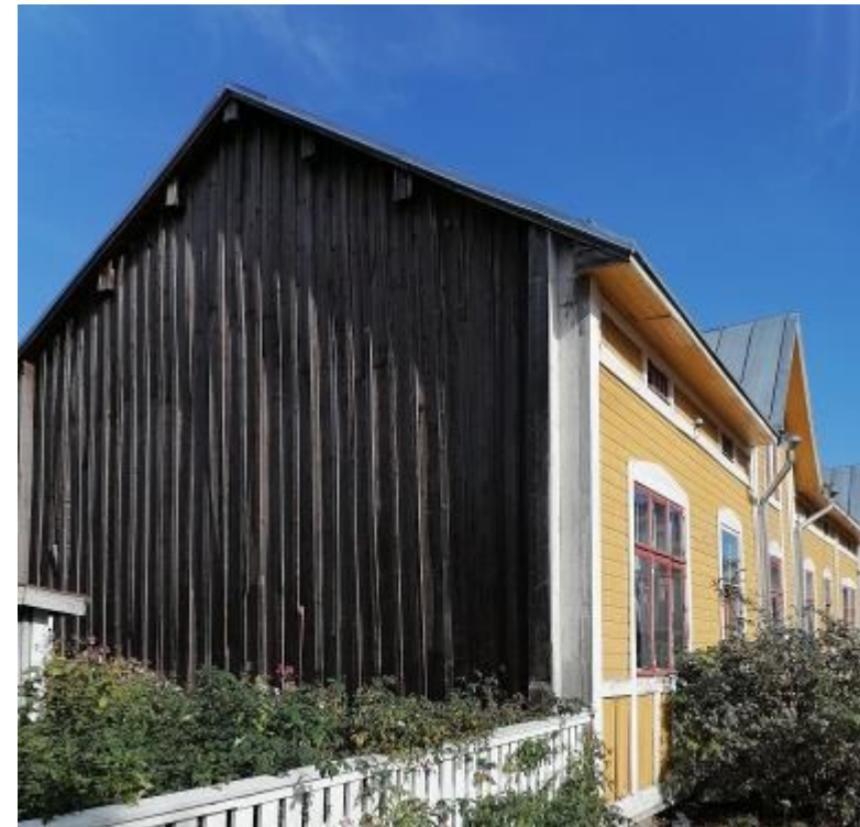
30 metriä pitkää rakennusta on vaikea saada kuvattu edestäpäin. Kadunpuolen julkisivu on muodistettu 1912-13-välisenä aikana. Samassa yhteydessä vaihdettiin ikkunat ja katolle tuli kaksi frontonia. Länsipädyn laudoitus on vanha ja punamultaus kulunut. Oikean puoleisessa kuvassa näkyy vaurioitunut piippu.
