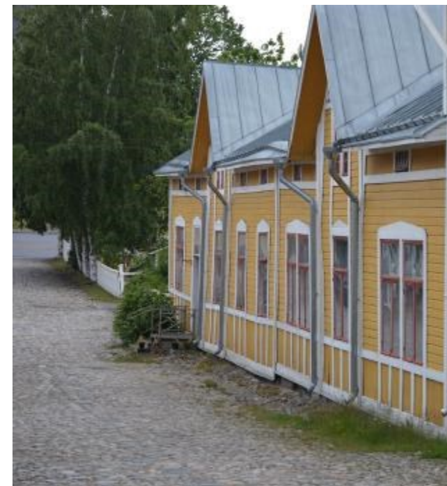
30 metriä pitkää rakennusta on vaikea saada kuvattu edestäpäin. Kadunpuolen julkisivu on muodistettu 1912-13-välisenä aikana. Samassa yhteydessä vaihdettiin ikkunat ja katolle tuli kaksi frontonia. Länsipädyn laudoitus on vanha ja punamultaus kulunut. Oikean puoleisessa kuvassa näkyy vaurioitunut piippu.
