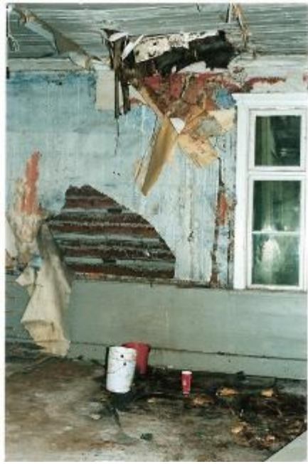
Vasemmanpuoleinen kuva on vuodelta 2003, jolloin rakennuksessa oli vesivaurioita. Oikeanpuoleinen kuva on uusi. Kuvat. T.L
