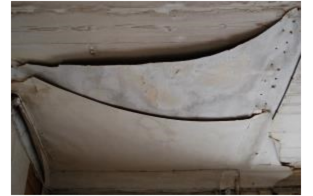
Katon vaiheet. Maalattu lautakatto ja 2x pin-
