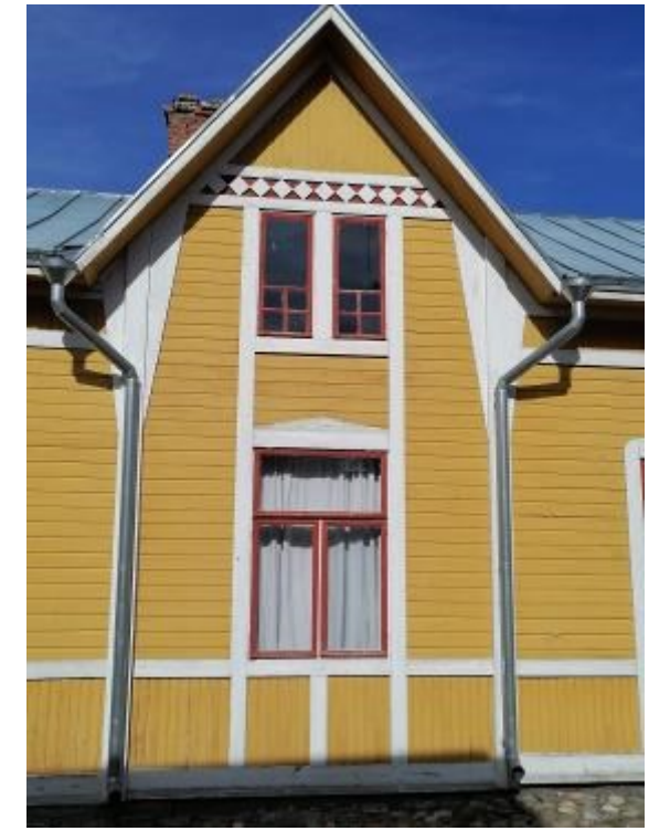
30 metriä pitkää rakennusta on vaikea saada kuvattu edestäpäin. Kadunpuolen julkisivu on muodistettu 1912-13-välisenä aikana. Samassa yhteydessä vaihdettiin ikkunat ja katolle tuli kaksi frontonia. Länsipädyn laudoitus on vanha ja punamultaus kulunut. Oikean puoleisessa kuvassa näkyy vaurioitunut piippu.
