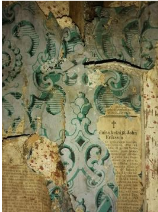
Kuvassa eteisen 10 kaapissa olevaa tapettia 1800-luvun puolivälistä, jossa painoväriä on vielä vihreää. Tapetin alla on roiskemaalauks. Kaapit rakennettiin 1830-luvulla. Makuuhuoneen tapetin päällä on vuodelta 1889.
