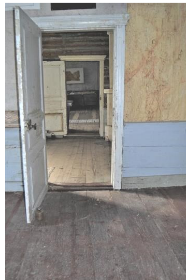
Kuva. Välitilan 3. marmoroitua seinää. Useimpien tilojen lattia on maalattu ensimmäisen kerran 1900-luvun alussa. Seinien paneloinneissa toistuvat harmaat, vaaleat ja vihertävät sävyt. Välitilan lattiassa on kaksi maalikerrosta, joista varhaisempi on vihertävän harmaa. Seinien maalina on liimamaali ja paneeleissa, ovissa ja latioissa on liimamaaleja.
