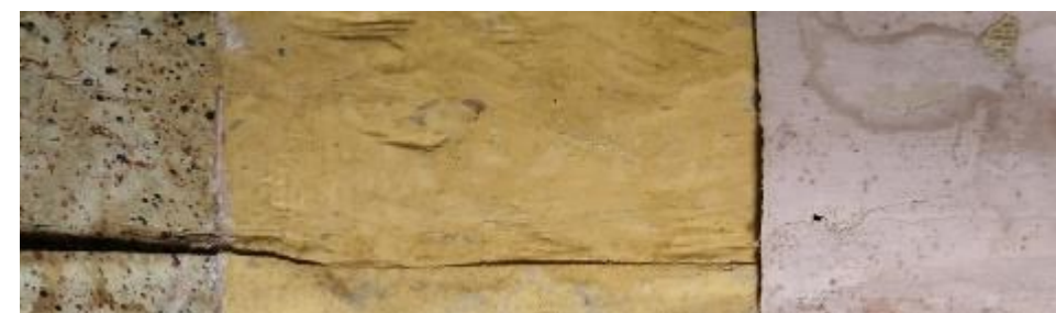
Kuva. Eteisen 10. kaapissa olevia liimamaalipintoja. Seinä on ollut näkyvillä ennen kaappien rakentamista. Keltainen roiskemaalauus on aiemmin kuvatun eteisen pystyraitaisen koristemaalauksen päällä ja seuraavana vaiheena on keltainen liimamaali ja seuraavana, uuden paperoinnin päälle tehty vaaleanpunainen liimamaali.
