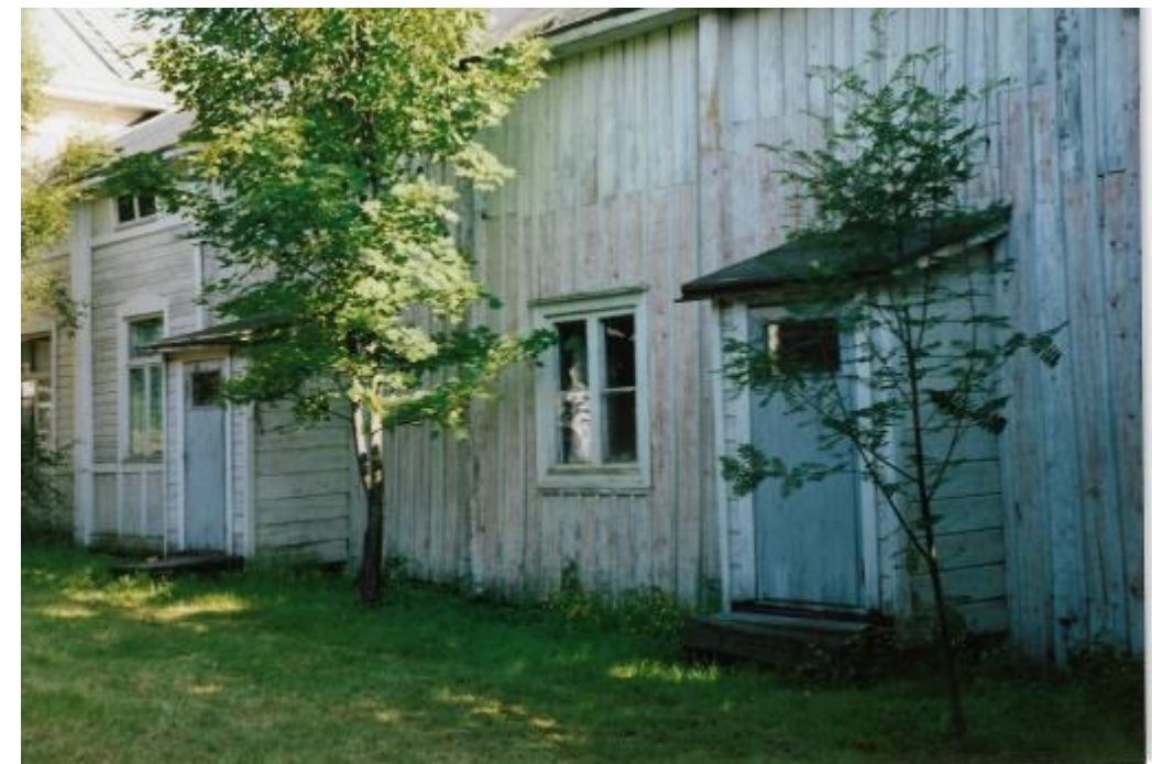
Starcken talo pihan puolelta 1990-luvulla. Tarkkaan katsoen seinäpinnassa voi nähdä jatkoskohdan, joka viittaa rakennuksessa tapahtuneisiin korotuksiin. Kuva N. Wennman 1990.
