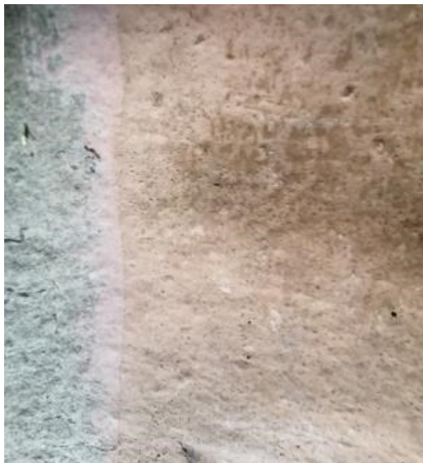
Porrashuoneen seinään liisteröityä lumppuhuopaa, joka on maalattu liima- maalilla vaaleanpunaiseksi. Kuva. L.O
