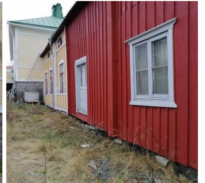
30 metriä pitkää rakennusta on vaikea saada kuvattu edestäpäin. Kadunpuolen julkisivu on muodistettu 1912-13-välisenä aikana. Samassa yhteydessä vaihdettiin ikkunat ja katolle tuli kaksi frontonia. Länsipädyn laudoitus on vanha ja punamultaus kulunut. Oikean puoleisessa kuvassa näkyy vaurioitunut piippu.
